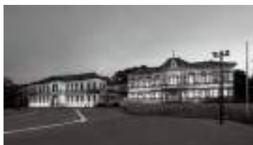
竣工写真（屋景）
