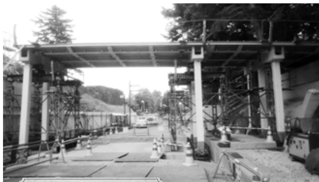
木装前の状況（鋼構造）
