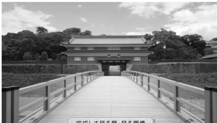
完成した鼠多門・鼠多門橋
