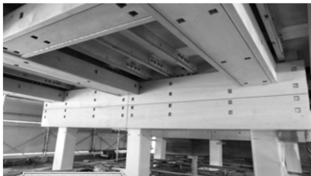
木装の施工状況
