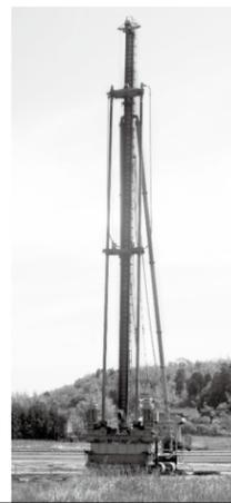
弱地盤であったため、サーチャージによる軟弱地盤対策を行いました。上山田市内では、軟弱地盤の層厚が20mと厚く、サーチャージでは対応できないため、深層混合処理による地盤改良を採用しました。本道路が緊急輸送道路に指定されていることも踏まえ、長期的に安定した構造とすることはもとより、大規模地震時にも大きな損傷が生じないように整備を行いました。
