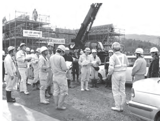
現地見学会(能越道工事現場)
