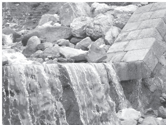
水通底(甚之助谷上流第16号堰堤)
