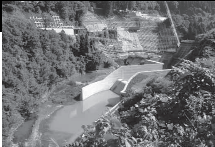
見学用の展望台から見た工事中の辰巳ダム
