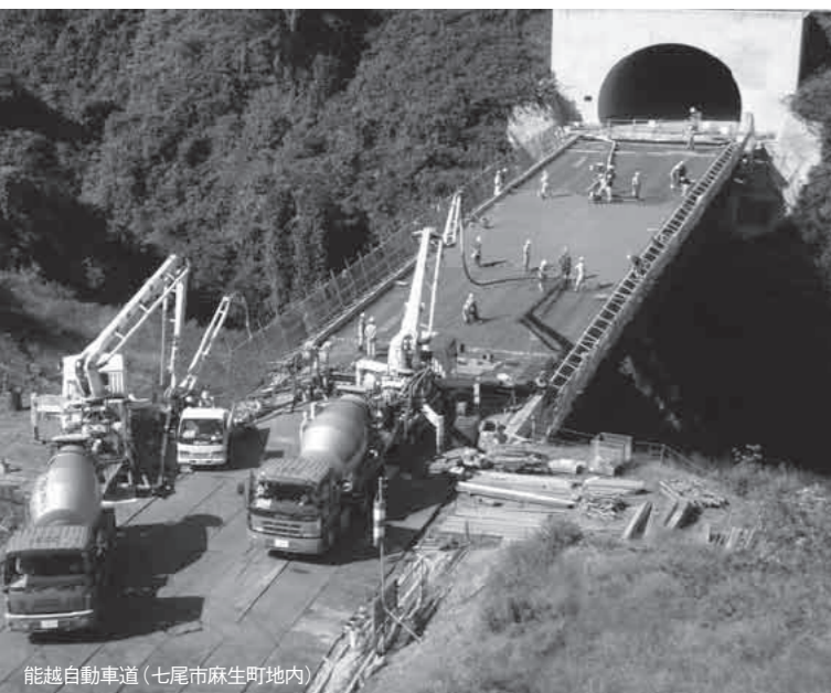
能越自動車道（七尾市麻生町地内）
