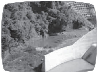
ダムのすぐ近くにある東取水口
