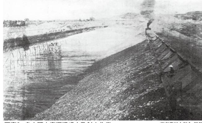
写真1 烏山頭水庫堰堤盛土及射水作業
