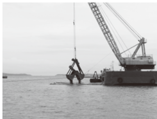
▲置換砂投入工
