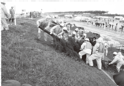
▲木流し工の様子
