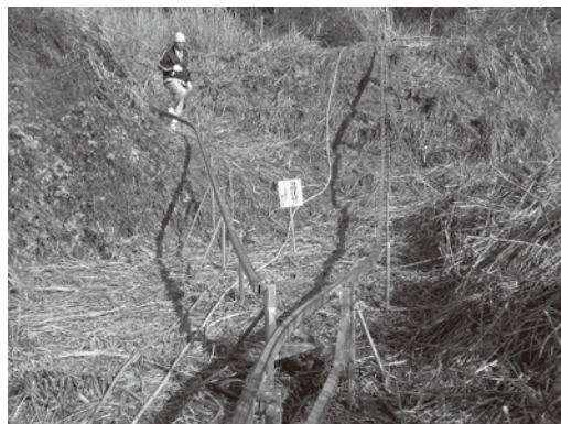
モノレール架設
