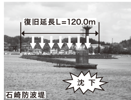
既設防波堤 地震後被災写真
